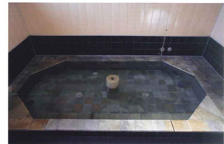
長野県東御市 カクイチ建材工業研修棟 浴槽縁、浴槽内壁、浴槽床、湯口
